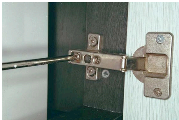
Het afstellen van een deur
